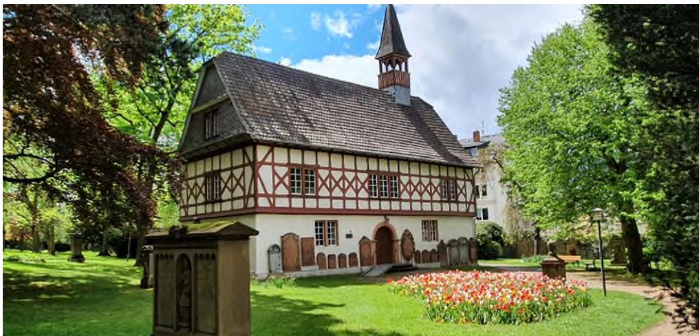
Abb. 3: Die Kapelle auf dem Alten Friedhof in Gießen, Nordseite.
