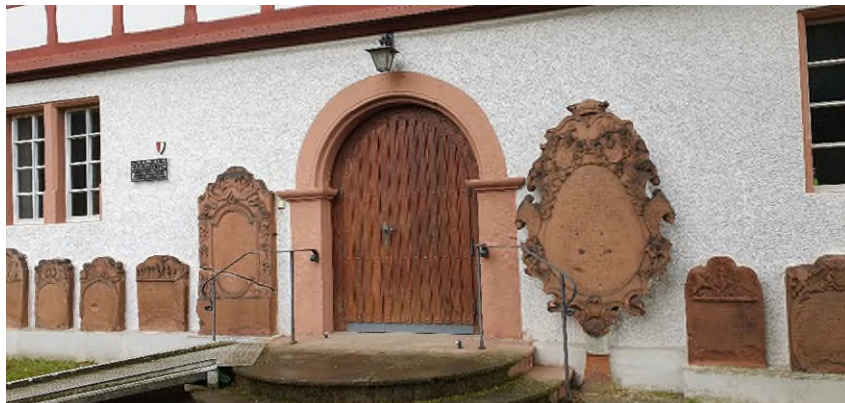
Abb. 5: Nordwand der Friedhofskapelle.
